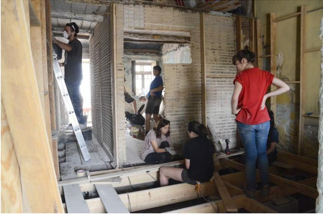
Aufgaben der Studenten umfassten die Installation einer Küche und eines Badezimmers, die thermische Isolierung aller Räume, das Bauen eines Solarwarmwasserbereiters, sowie das Bauen von Möbeln, Türen und Fenstern.
